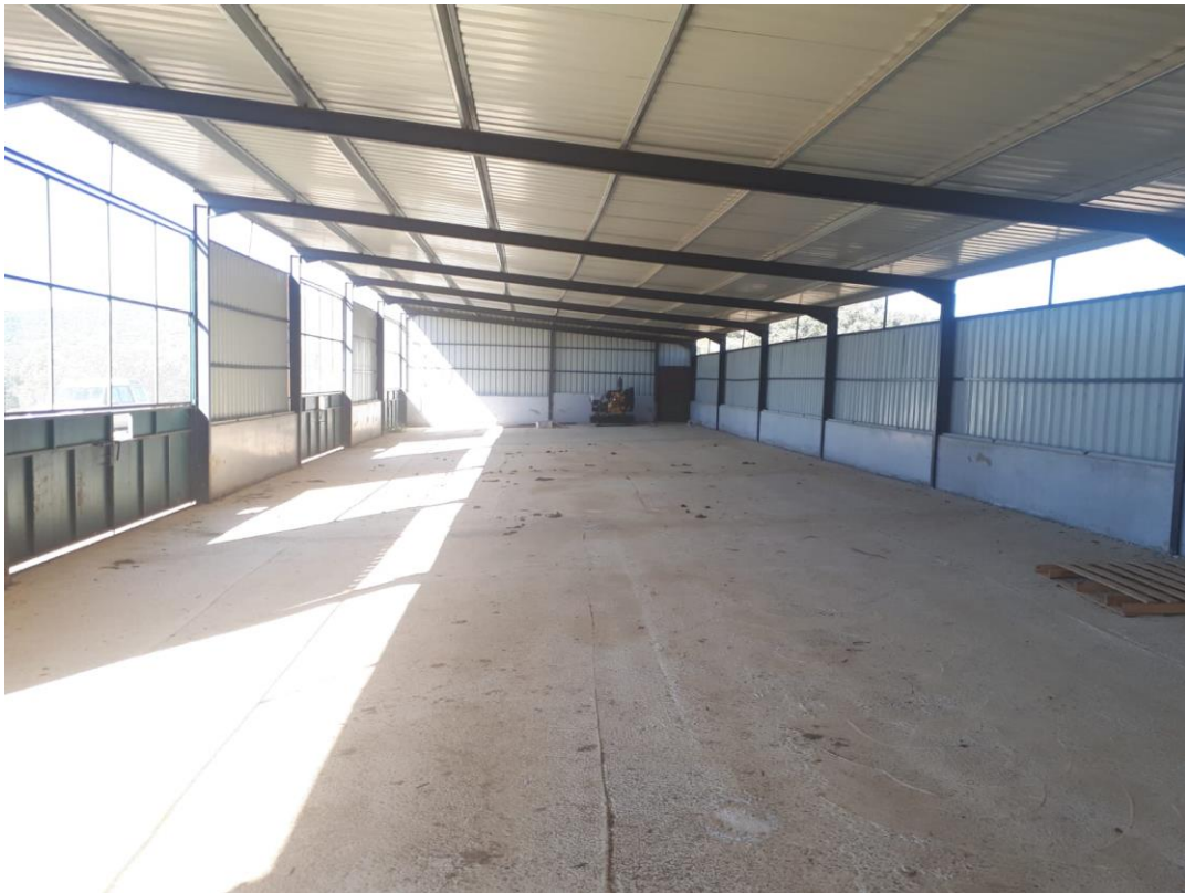
Foto 3: Interior de la nave de secuestro.
