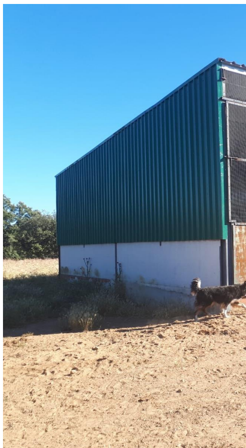
Foto 9: Alzado posterior de la nave de secuestro.
