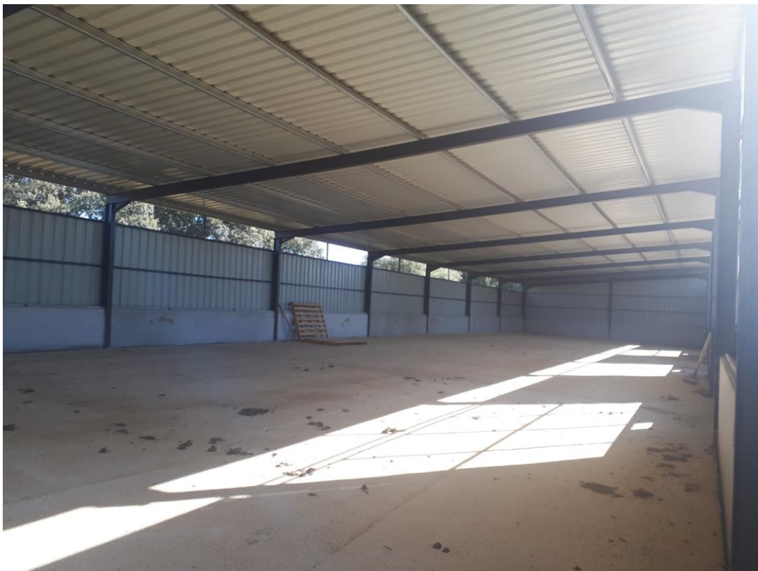
Foto 4: Interior de la nave de secuestro.
